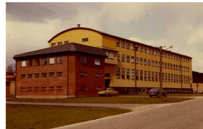
Fabrik uppförd för Kinnahults väveri 1946–1947. Byggnaden har ett utmärkande läge mitt i det riksintresse för kulturmiljövården som Häggåns dalgång utgör.
