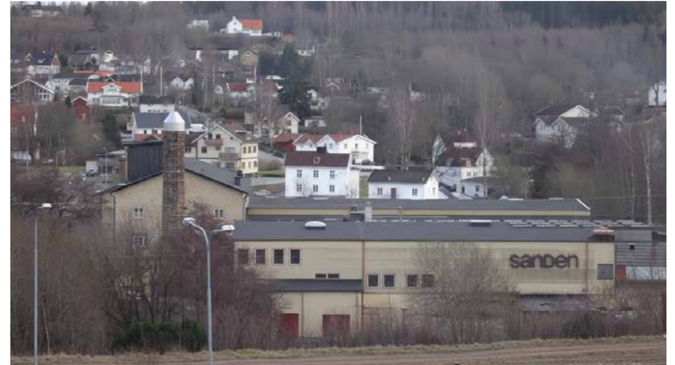
Parti av f.d. Kinnasand. Stora delar av anläggningen tillkom under 1940- och 1950-talen.
