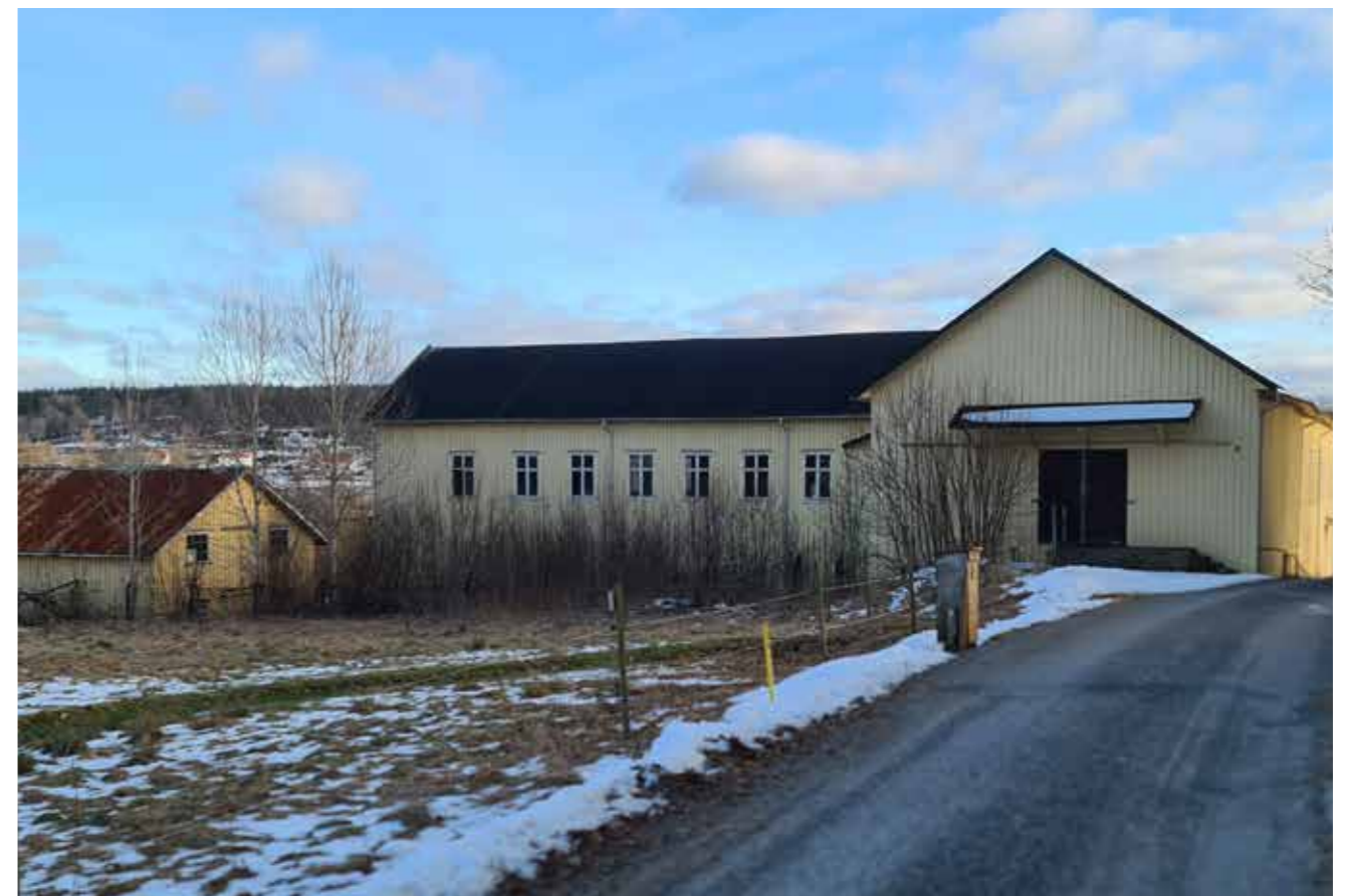
Pettersson & Tisell i Kinnahult, en välbevarad fabriksbyggnad i trä från 1908.
